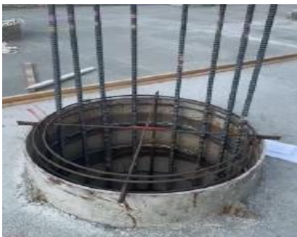
TPボトムパイルバスケット工法の例
